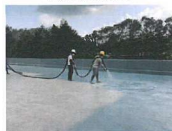
醫院屋頂施工
