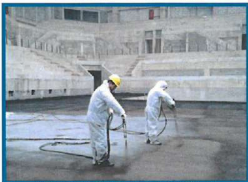
噴塗速凝橡膠防水塗料施工
