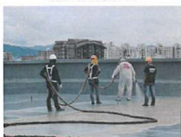
飯店屋頂施工
