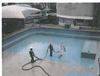
飯店屋頂施工
