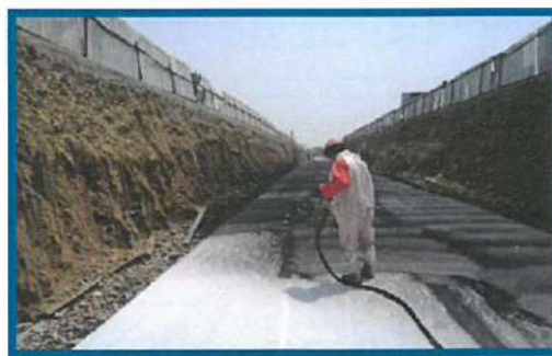
噴塗速凝橡膠防水塗料施工
