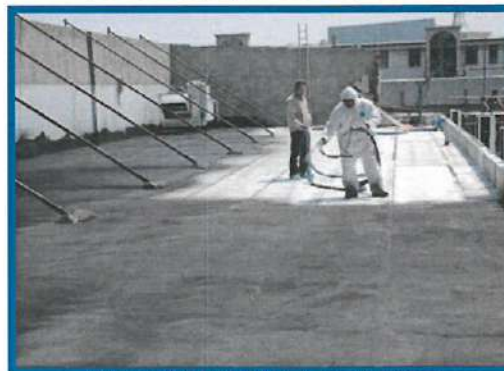
噴塗速凝橡膠防水塗料施工
