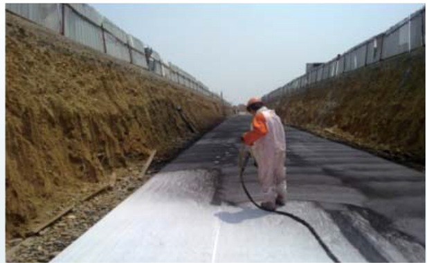
噴塗速凝橡膠防水塗料施工
