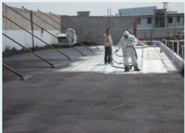
噴塗速凝橡膠防水塗料施工
