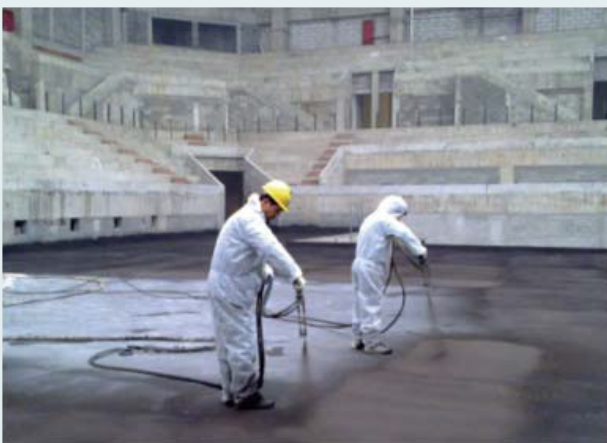
噴塗速凝橡膠防水塗料施工
