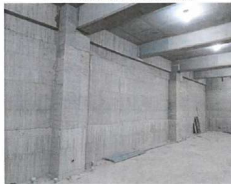
地下側牆拆模後狀況
