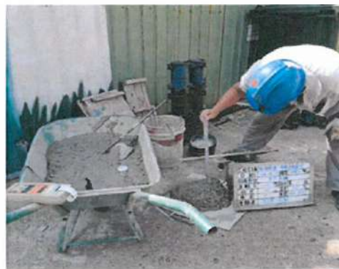
澆築現場測坍落度
