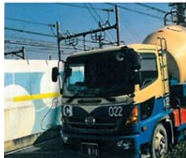
5 混凝土车到工地
