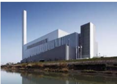
东淀清扫工厂—地下工程
