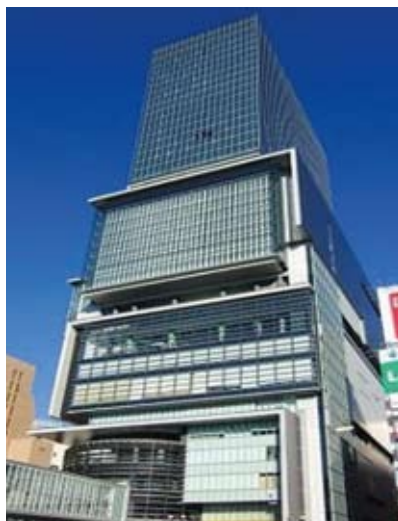
澁穀ヒカリエ—地下工程
