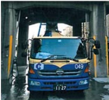
4 混凝土装载出车
