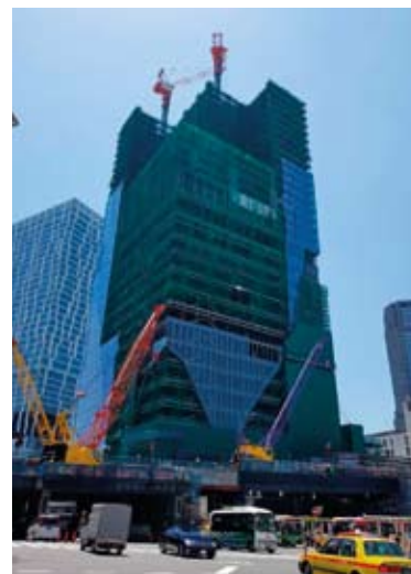
东京涉谷车站街区东栋新建筑工事— 地下工程
