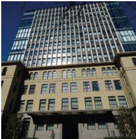
早稲田大学D栋(政治経済学部)— 地下工程
