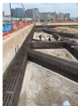
深圳市前海交通枢纽地下6层立 墙面防水工程，重点部位采用 BESTONE混凝土灌注
