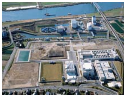
ちば野菊の里浄水場—上下水道・水槽・排水施設
