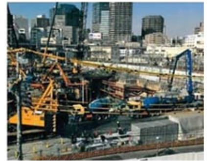
6 地下工程灌浆防水施工
