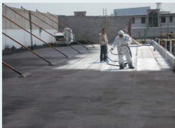
噴塗速凝橡膠防水塗料施工
