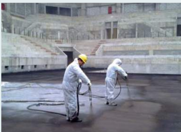
噴塗速凝橡膠防水塗料施工
