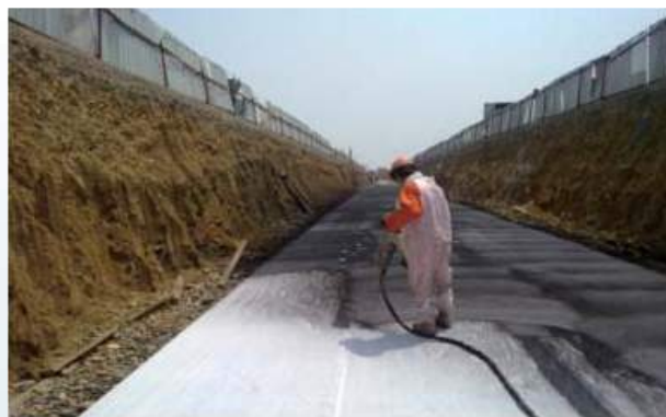
噴塗速凝橡膠防水塗料施工
