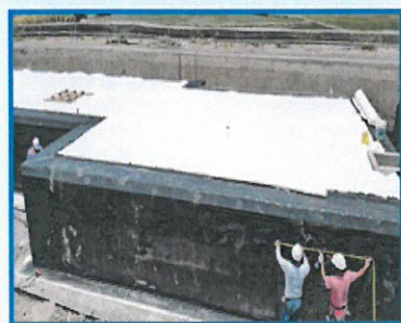
防水膜、保護不織布包覆雨水積磚
