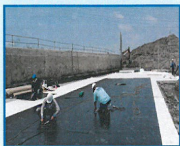
保護不織布、防水膜鋪設搭接
