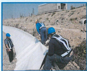
大湖底部防水膜鋪設
