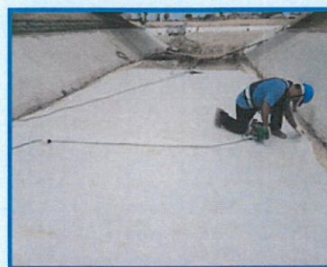
大底底部防水膜鋪設焊接
