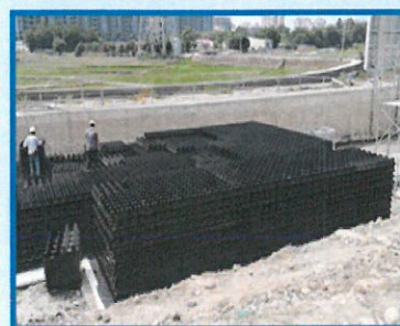
雨水基磚鋪設
