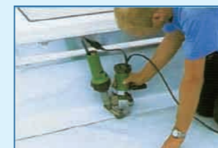
屋面PVC防水膜材的圓弧焊接面。
