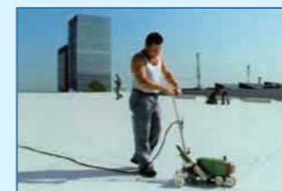
屋面PVC防水膜的搭接焊。
