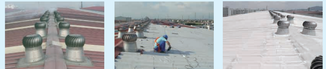
金山八煙溫泉會館輕鋼屋頂
